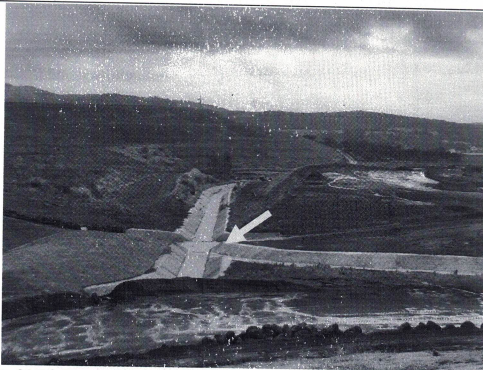
Foto 21- Vista superior do canal de cintura e canal extravasor respectivamente
