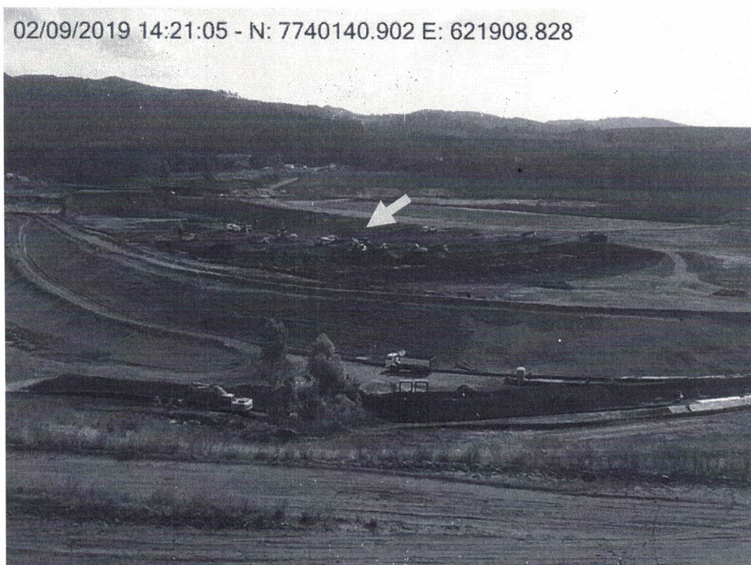
Foto 12- Registro de avanço da terraplanagem
