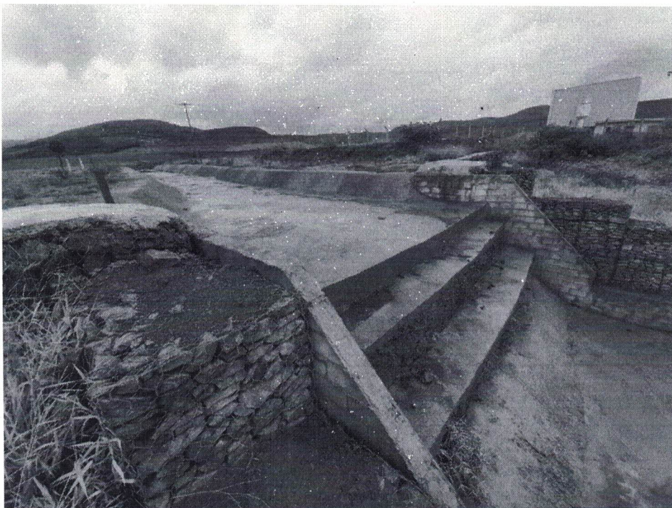
Foto 18- Vista superior de drenagem implantada em trecho parcial da área de montante
