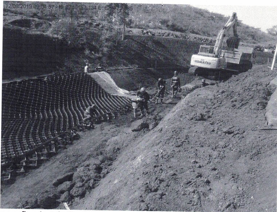
Foto 5- Preparação e instalação da geócelula e bidim no canal para posterior concretagem e na sequência avanço da escavação do canal
