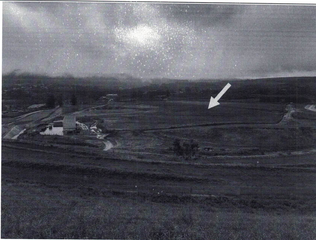
Foto 15- Vista lateral atual da área pós-conclusão das obras- Foto de 05.02.2021
