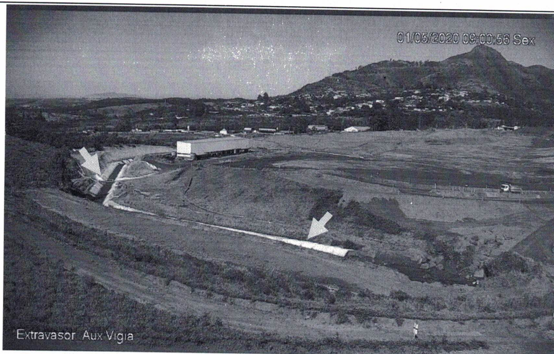
Foto 9- Vista lateral do canal extravasor parcialmente implantado
