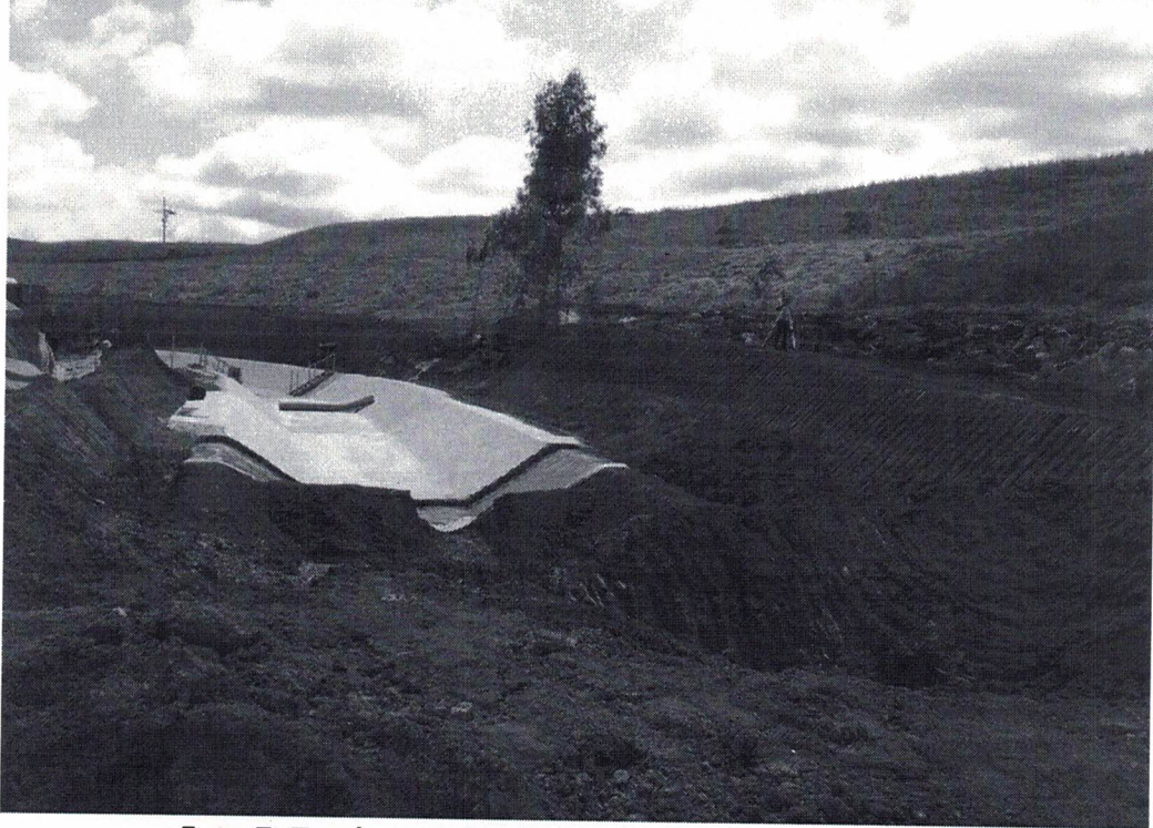
Foto 7- Trecho parcial do canal extravasor concretado
