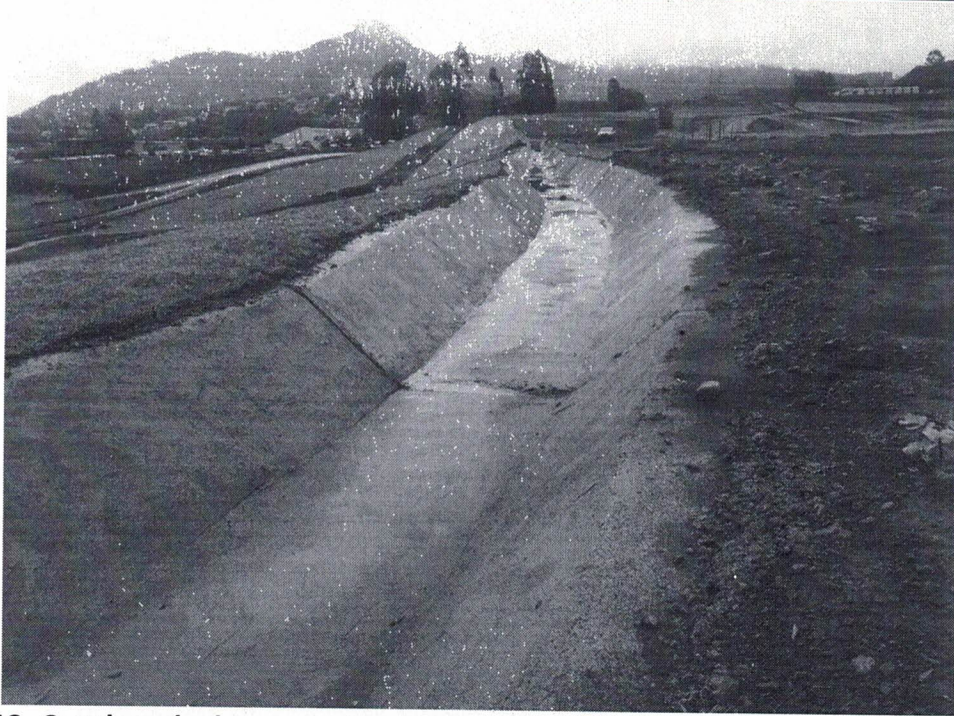
Foto 19- Canaleta de drenagem implantada interligando a saída do canal extravasor
