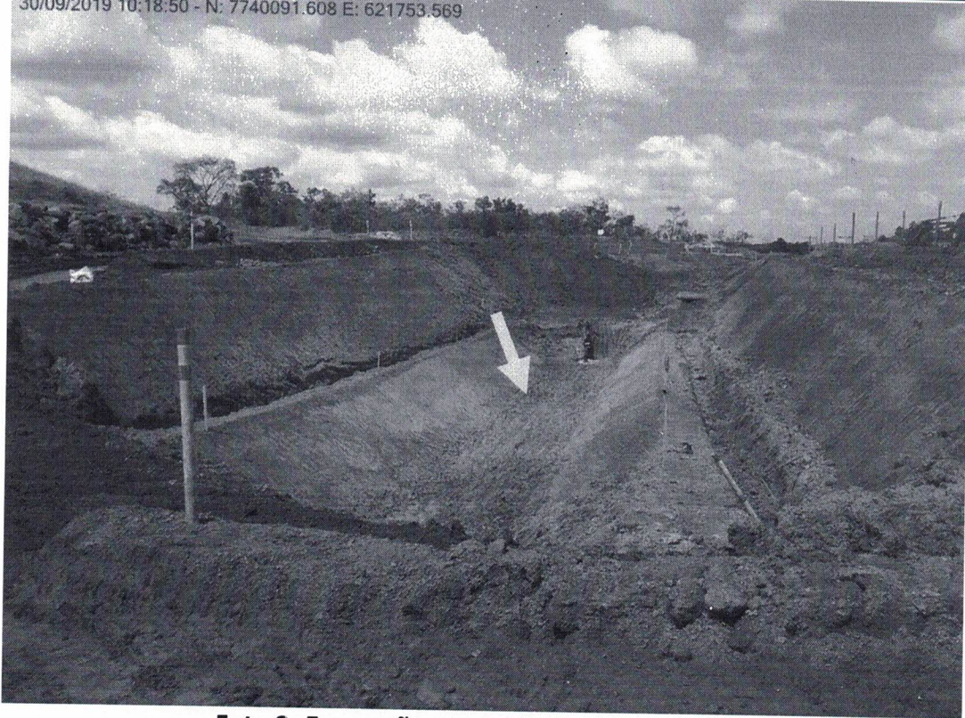
Foto 3- Escavação parcial do canal extravasor
