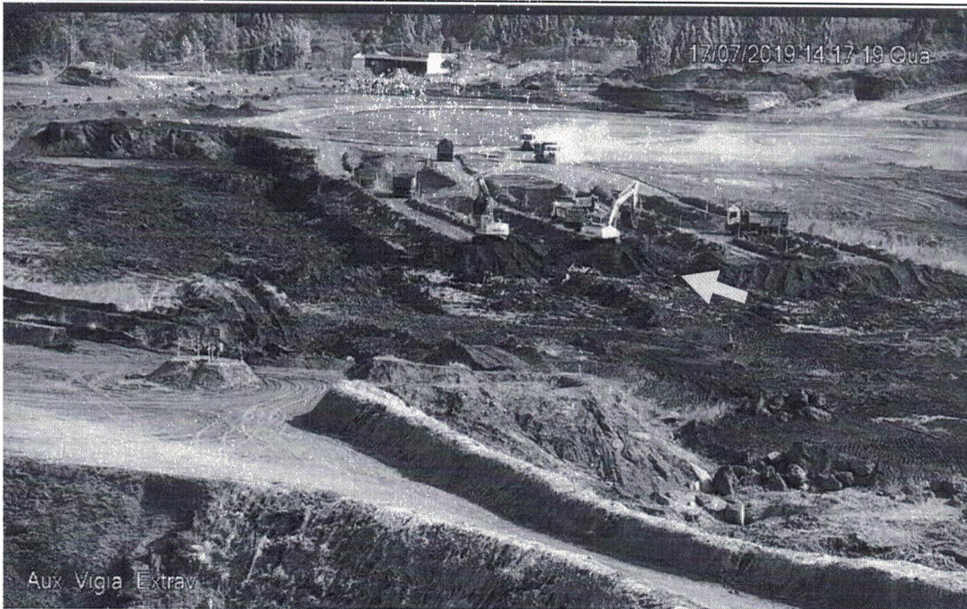
Foto 11- Evolução da escavação e remoção do rejeito a montante
