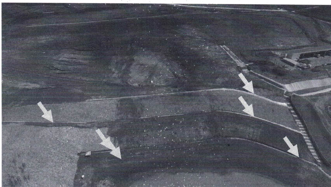
Foto 16- Drenagens superficiais adjacentes implantadas e interligadas ao canal extravasor e canal de cintura
