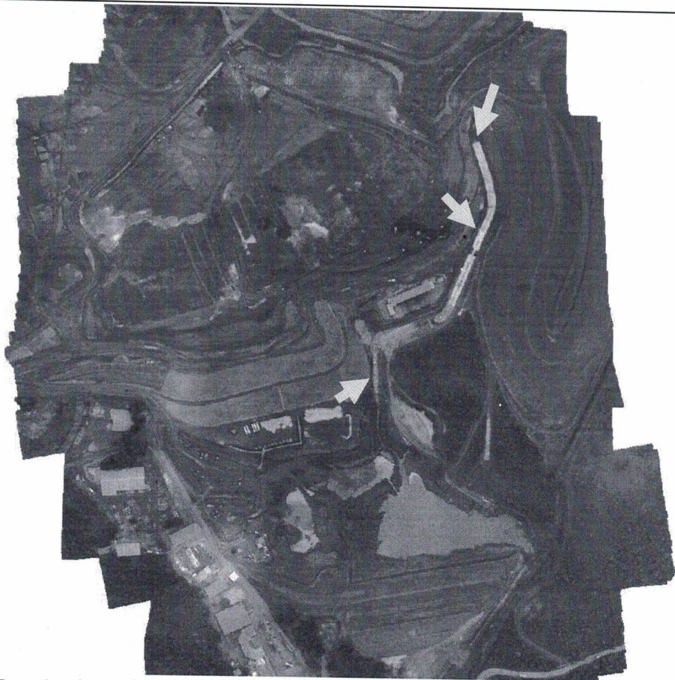
Foto 2- Vista aérea do início de implantação parcial do canal extravasor
