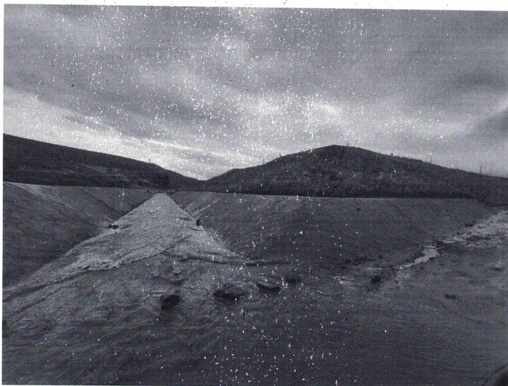
Foto 22- Vista aproximada parcial do canal extravasor e canal de cintura respectivamente
