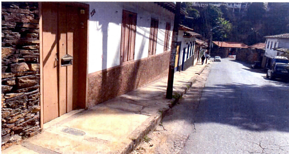
Imagem 03: Piso reconstituído após instalação de hidrômetro
