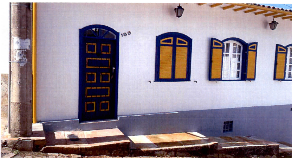
Imagem 04: Piso reconstituído após instalação de hidrômetro
