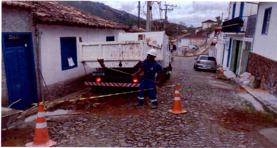
Imagem 01: Remoção de resíduos gerados na instalação dos hidrômetros
