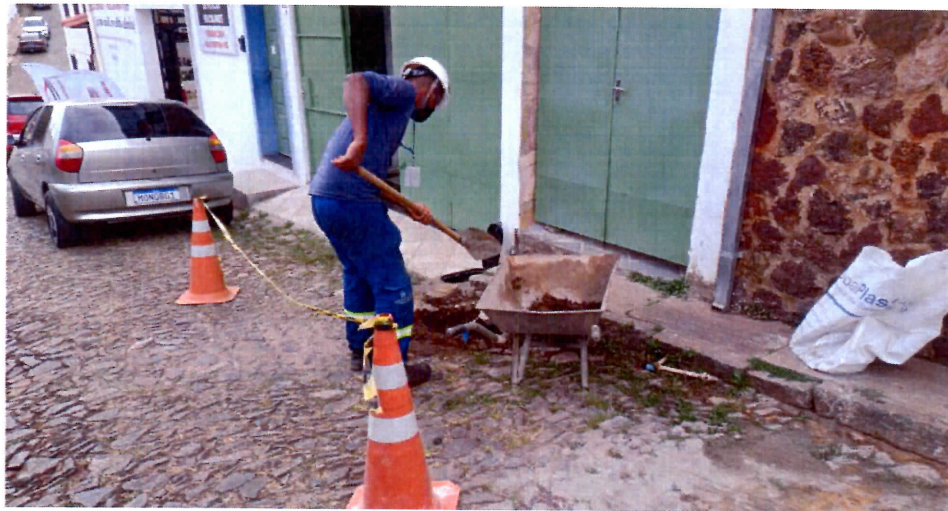
Imagem 02: Remoção de resíduos gerados na instalação dos hidrômetros
