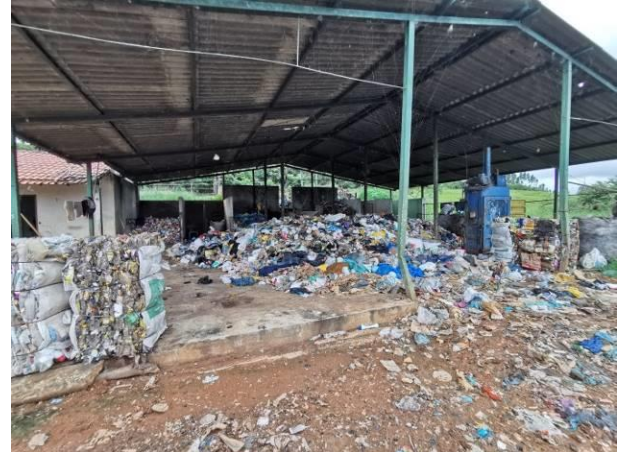
Figura 6 – Usina de triagem e compostagem
