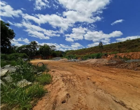
Figura 5 – Área de disposição de resíduos de construção civil
