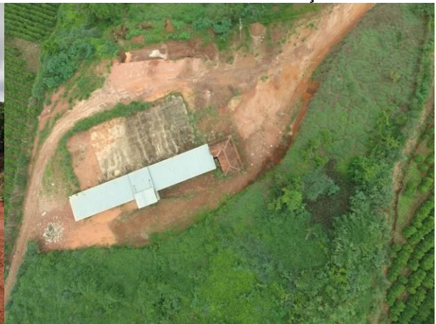
Figura 6 – Imagem de Drone - UTC desativa e área de transbordo em construção.
