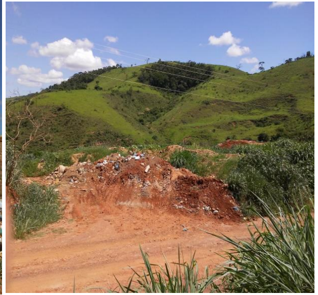
Figura 6 – Área de disposição de RCC localizada na UTC.
