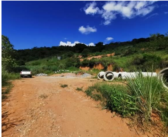
Figura 5 – Local de disposição de RCC
