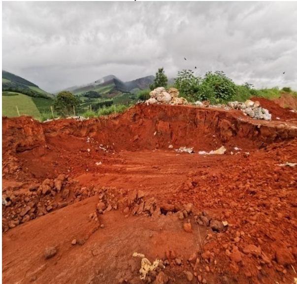
Figura 122—Local de disposição no município de Caputira.
