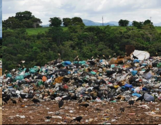
Figura 292– Disposição irregular e operação inadequada resultando em grande volume de RSU exposto e presença de animais.
