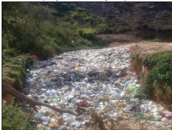
Figura 249– Vala de disposição final dos rejeitos oriundos da UTC, antes da cobertura com terra (frequência inadequada).
