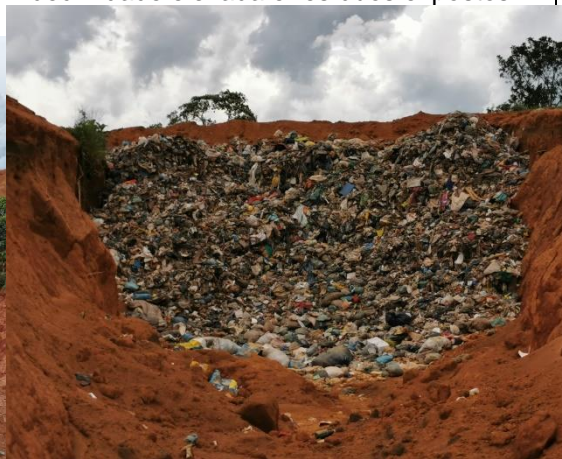
Figura 281–Local de disposição final de RSU do município de Paula Cândido. Observar declividade elevada e resíduos expostos.
