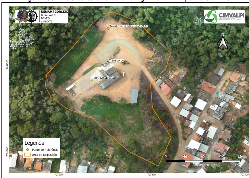
Figura 235– Vista aérea da área do antigo lixão municipal de Coimbra.
