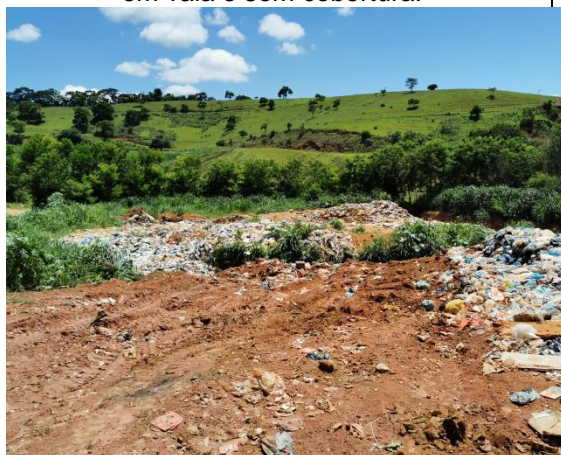
Figura 327– Vista do local de disposição irregular de RSU de Urucânia. Observar grande quantidade de resíduos dispostos em vala e sem cobertura.
