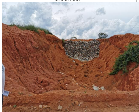
Figura 280–Vista geral do local de disposição final de RSU do municipal de Paula Cândido. Observar processos erosivos.
