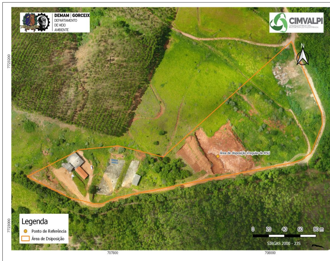
Figura 253– Vista aérea da área da UTC, onde estão localizados o transbordo e infraestrutura existente.
