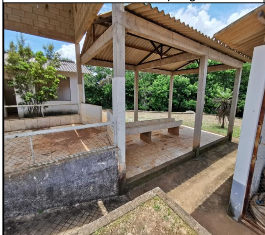
Figura 218–Infraestrutura da UTC desativada em Araponga.
