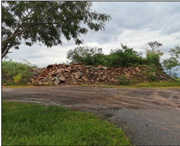
Figura 157– Área licenciada de disposição de RCC no município de Itabirito.
