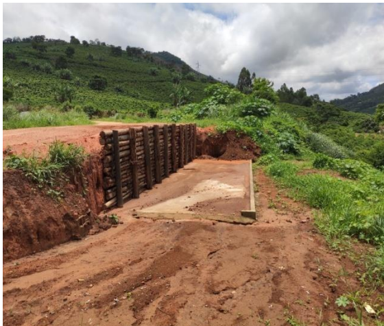
Figura 116– Construção da estação de transbordo de Sericita.
