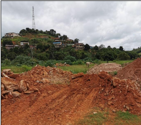
Figura 165– Área de disposição irregular de RCC no município de Ponte Nova.
