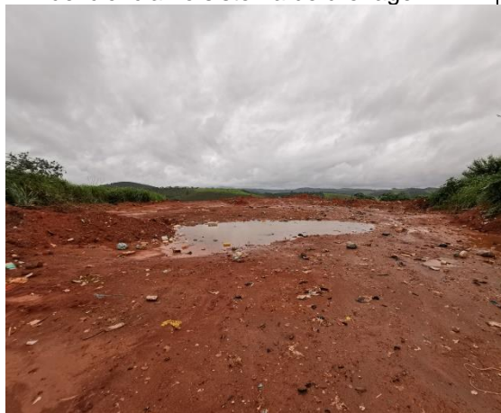
Figura 330– Vista geral do antigo local de disposição de RSU de Vermelho Novo. Observar acúmulo de água, indicando deficiência no sistema de drenagem.
