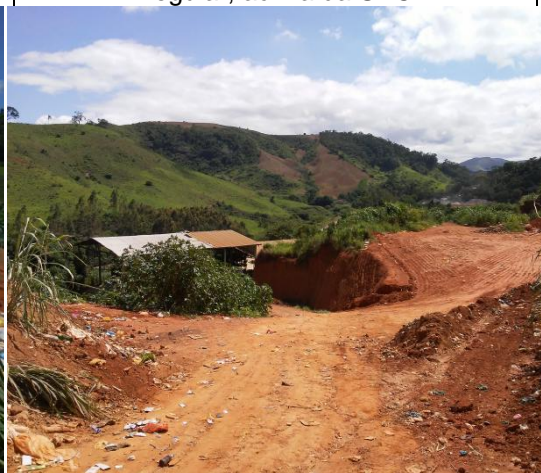
Figura 203–Local de disposição irregular de RSU do município de Abre Campo. Acesso a área de disposição irregular, acima da UTC.
