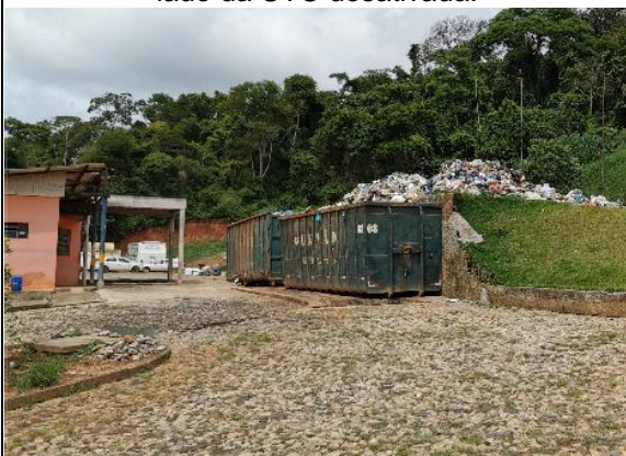
Figura 238– Área de transbordo construída ao lado da UTC desativada.
