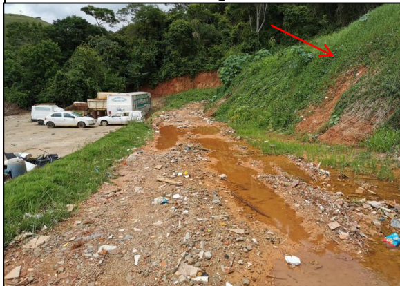
Figura 236– Antiga área de disposição final de RSU de Coimbra localizada em área adjacente à UTC do município (seta vermelha). Observar sistema de drenagem ineficiente.
