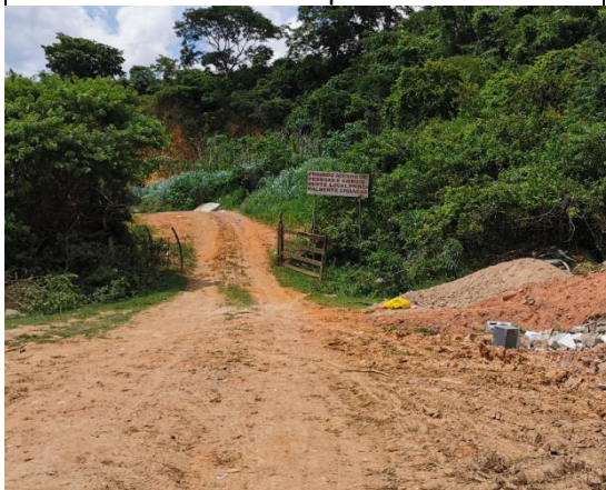
Figura 206– Acesso à área de disposição dos RSU no Município de Acaiaca.
