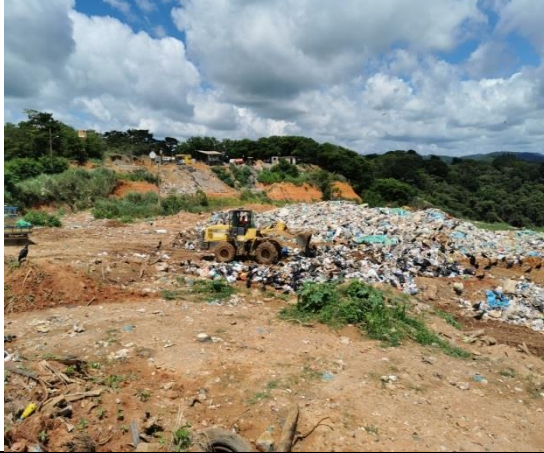
Figura 291– Área de disposição irregular (lixão) de RSU de Ponte Nova sem recobrimento com a frequência necessária.
