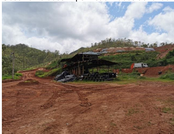
Figura 271– Vista geral do almoxarifado, Observar taludes impermeabilizados ao fundo.
