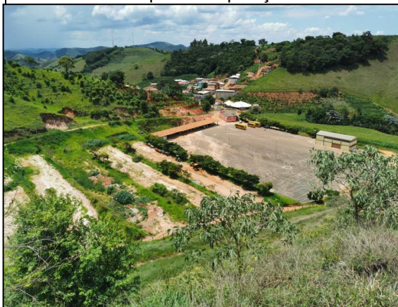
Figura 230–Vista geral do antigo local de disposição final de RSU do município de Canaã. Atualmente o local funciona como Parque de Exposições.
