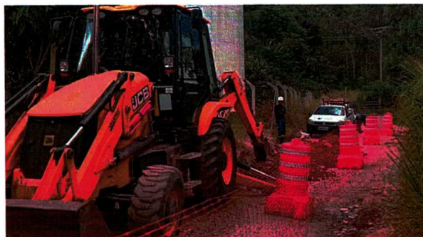
Imagem 01: Obras de ampliação de rede de abastecimento na localidade de Catete.
