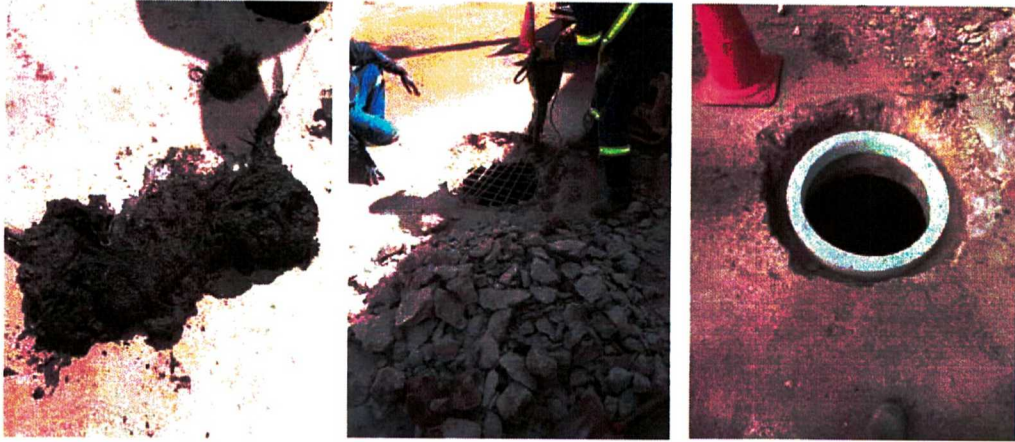
DESOBSTRUÇÃO DE REDE DE ESGOTO – RUA VEREADOR HÉLIO FERREIRA, ENGENHEIRO CORRÊA (06/08/2021)
