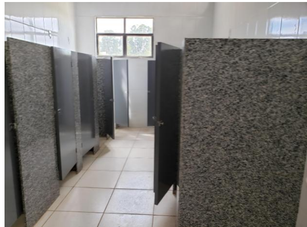
Foto 10: Vista parcial de um banheiro para funcionários
