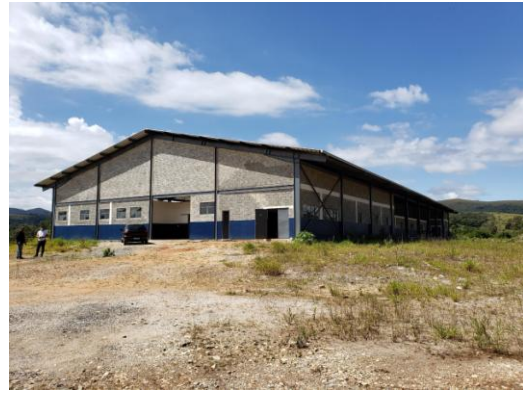
Foto 02: Vista da fachada principal
