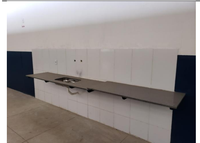
Foto 08: Vista parcial de local onde existe uma pia com bancada
