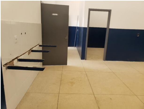
Foto 07: Vista parcial de local onde existia uma bancada
