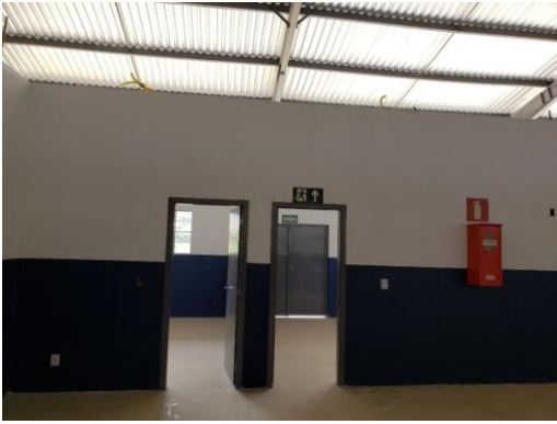
Foto 13: Vista parcial de entrada de salas
