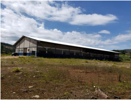
Foto 01: Vista parcial do galpão
