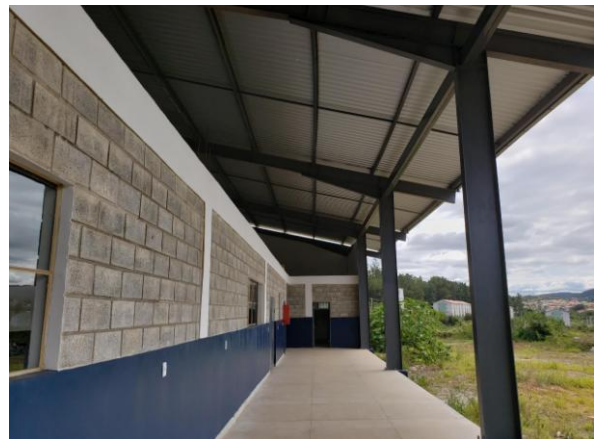
Foto 04: Vista parcial da lateral do imóvel
