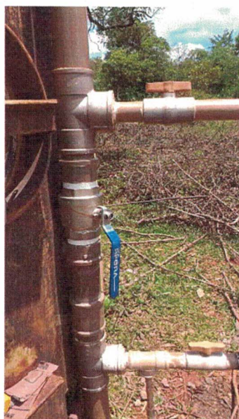
Imagem 02: Substituição de registro, reservatório de Mota (10/12/2021)
