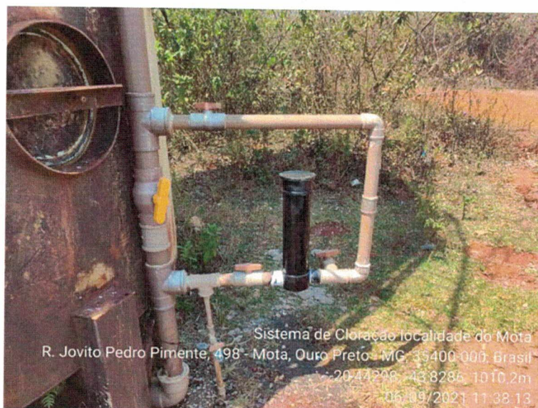
Imagem 01: Instalação de novo sistema de cloração/desinfecção, reservatório de Mota (06/09/2021)
