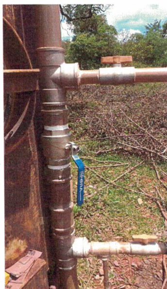
Imagem 02: Substituição de registro, reservatório de Mota (10/12/2021)
