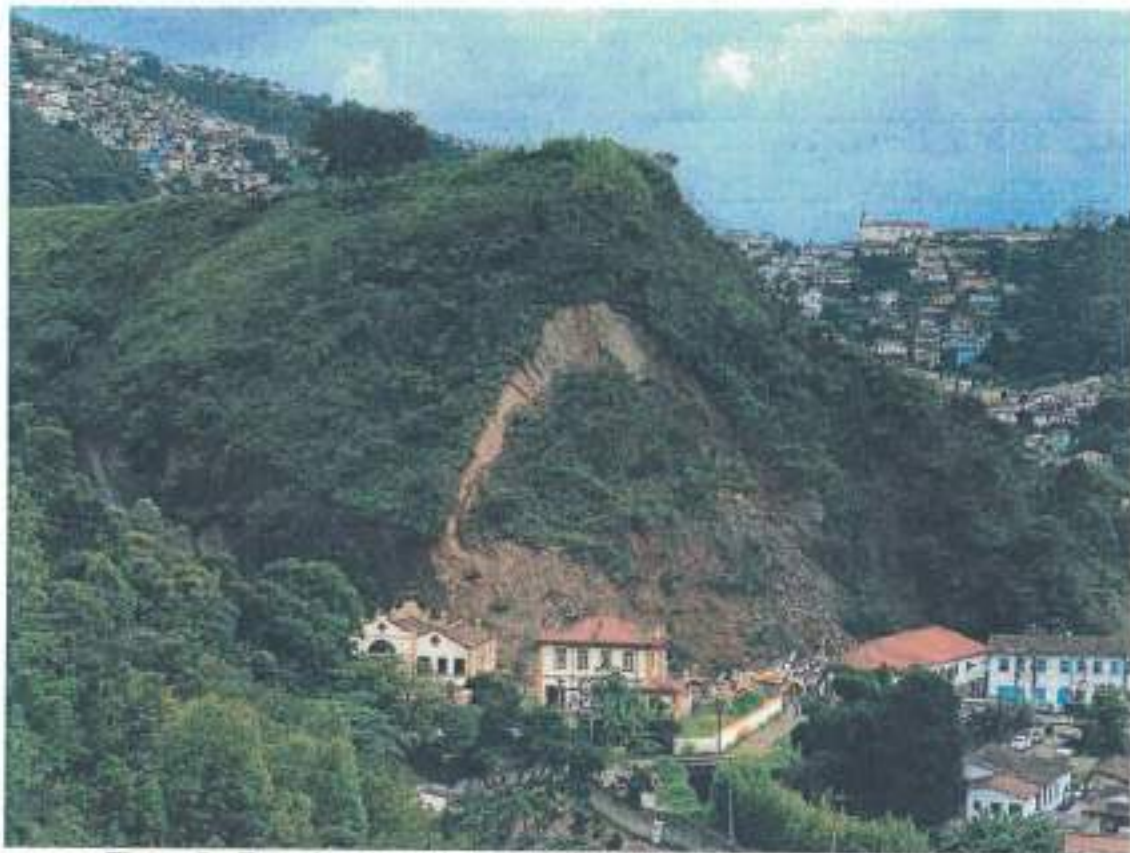
Figura 2 : Foto do talude do Morro da Força após deslizamento de solo.
