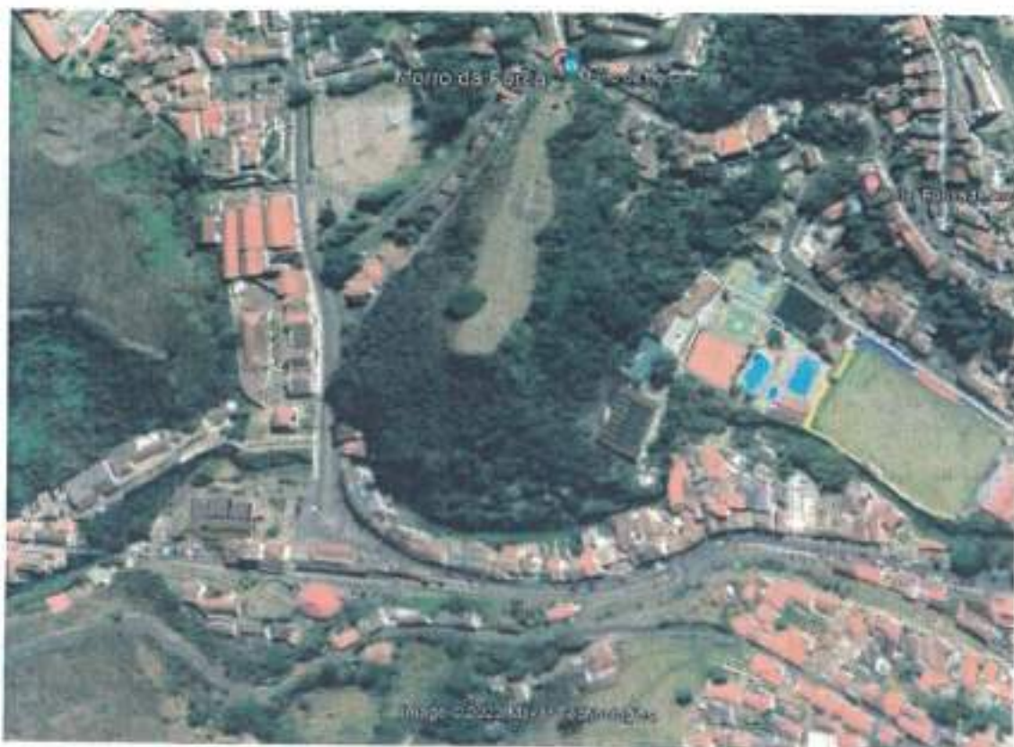
Figura 3 : Vista aérea do Morro da Força antes do deslizamento de solo.
