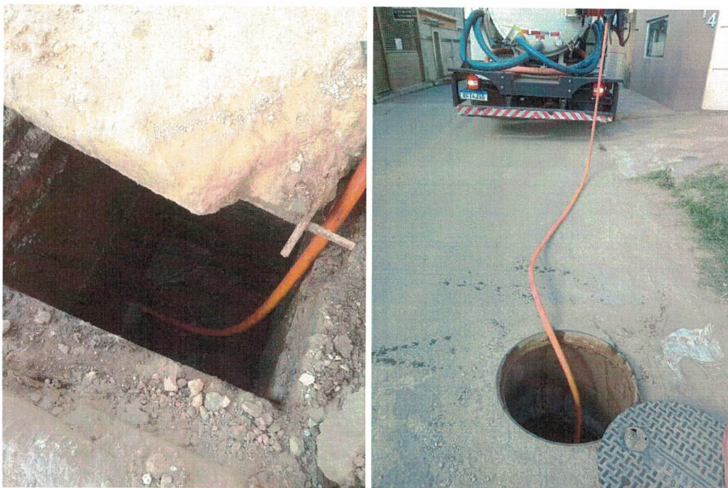
REPARO REDE DE ESGOTO, RUA OLARIA, Nº 177, AMARANTINA (02/06/2022)
