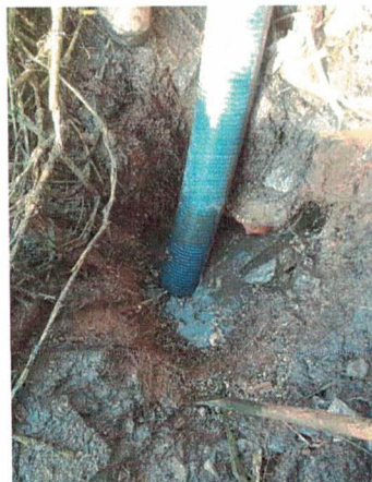
REPARO REDE DE ESGOTO, RUA OLARIA, Nº 177, AMARANTINA (02/06/2022)
