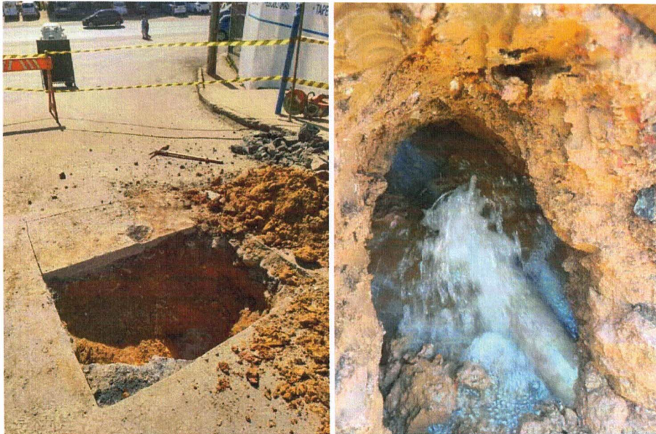
REPARO DE ADUTORA, AVENIDA RAMIRO GONÇALVES DA SILVA, CACHOEIRA DO CAMPO (29/07/2022)
