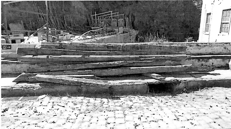
FIG.: Algumas peças estruturais de madeira resgatadas.
