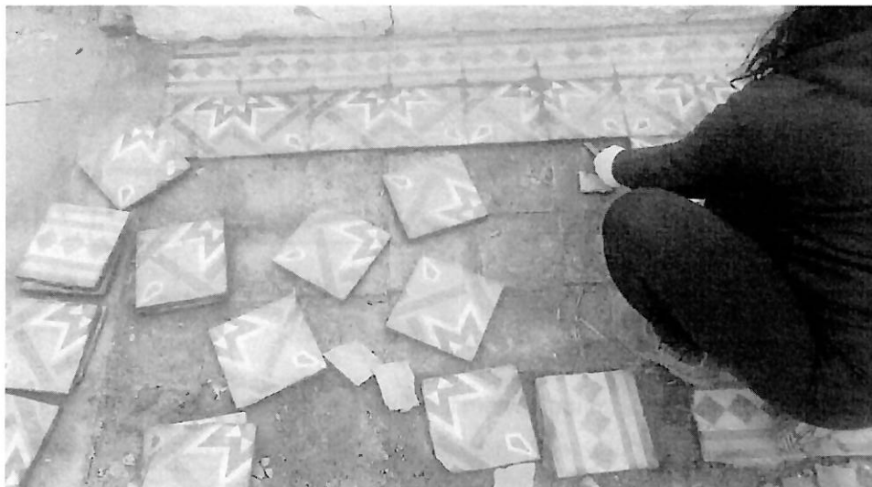
FIG.: Retirada dos ladrilhos hidráulicos.
