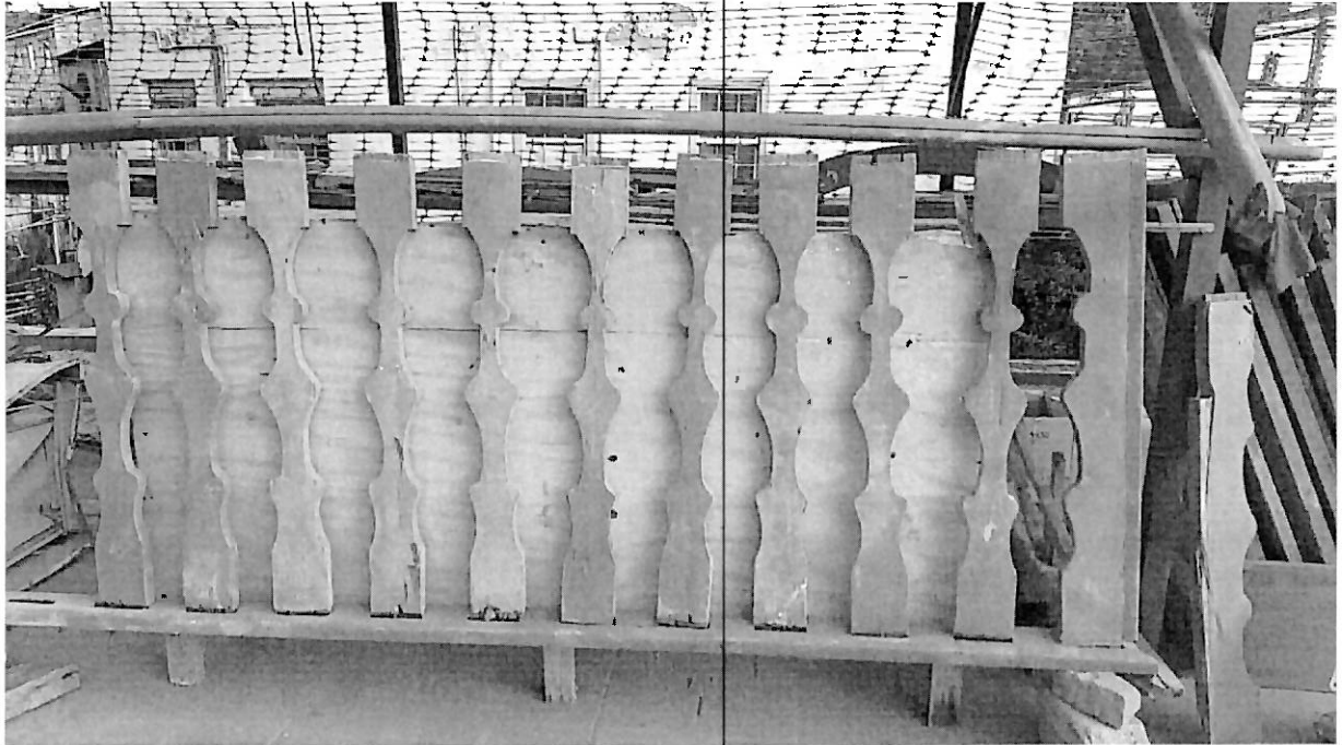
FIG.: Detalhe do guarda corpo da escada.
