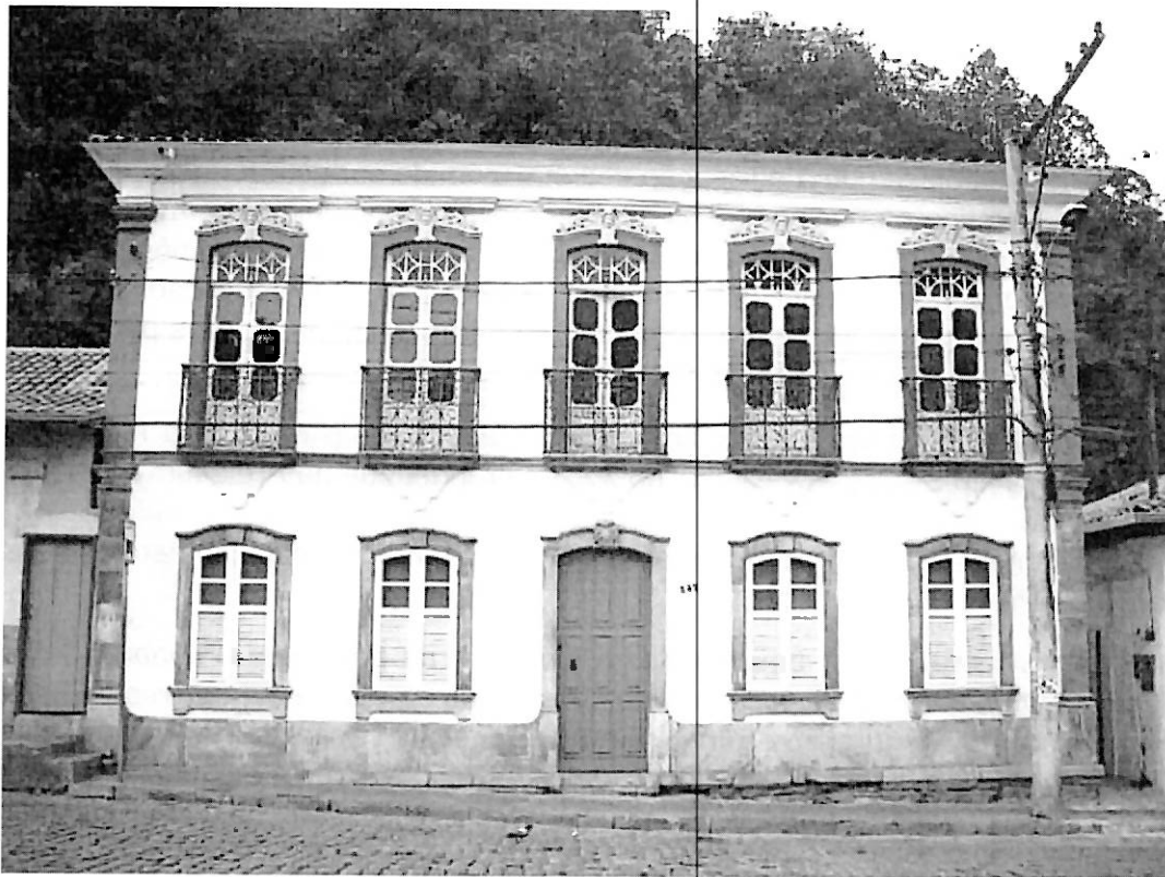
Imagem 1 – Fachada principal do Solar Baeta Neves. Autos: Guilherme I. Nunes Ataídes.
