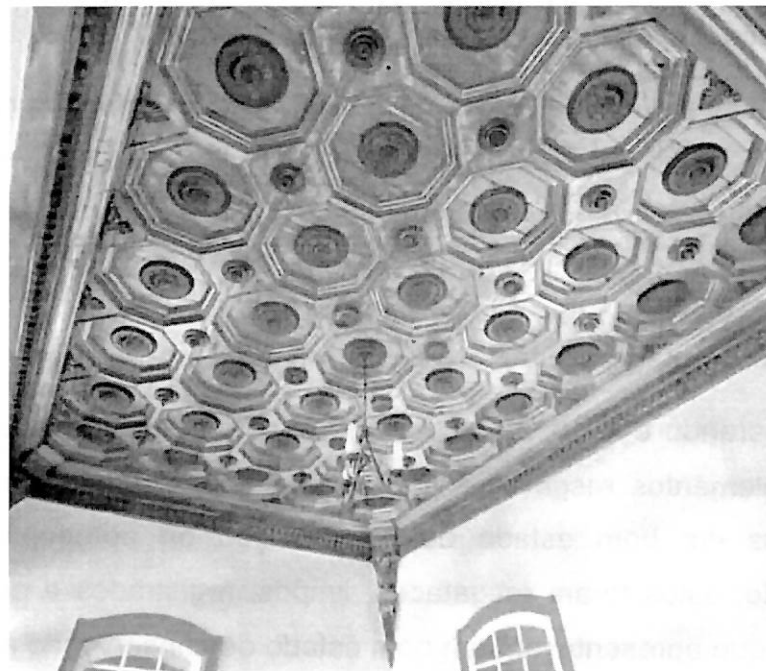
FIG.: Forro apainelado do Salão Principal
