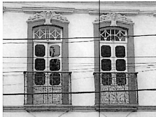
FIG.: Detalhe das esquadrias com sobrevergas decoradas do segundo pavimento da fachada frontal
