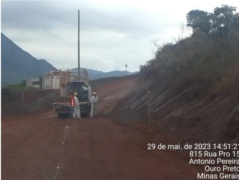
Figura 10: Aplicação de hidrossemeadura.
