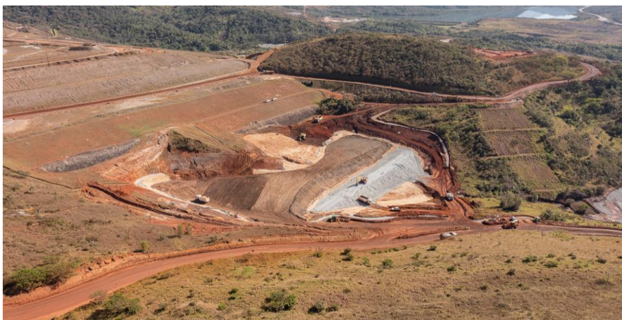
Figura 3: Obras do Dique 1 (Imagem do dia 23/08/2023)
