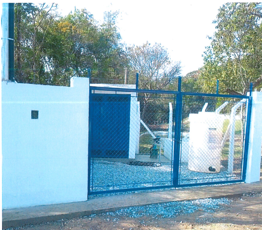
INSTALAÇÕES NOVO POÇO LOCALIDADE DE RIACHO, DISTRITO DE AMARANTINA
