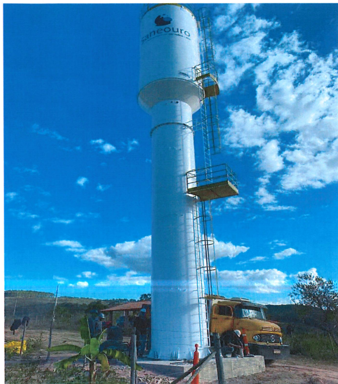
NOVO RESERVATÓRIO INSTALADO PELA SANEOURO, LOCALIDADE DE RIACHO, DISTRITO DE AMARANTINA
