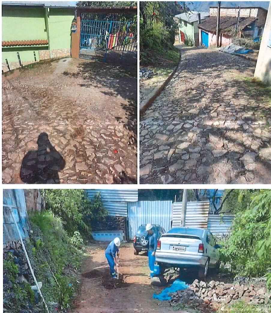
REPAVIMENTAÇÃO/CALÇAMENTO RUA MAESTRO JOAQUIM ANICETO (AGOSTO/2023)
