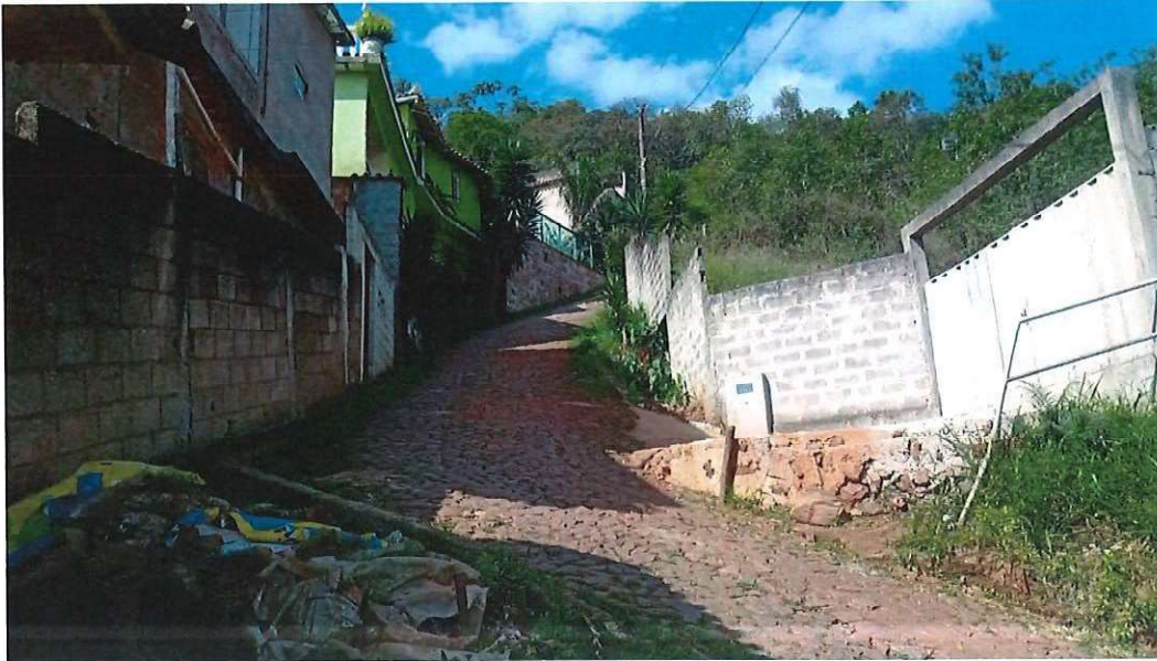
VISTORIA CALÇAMENTO RUA MAESTRO JOAQUIM ANICETO (23/10/2023)
