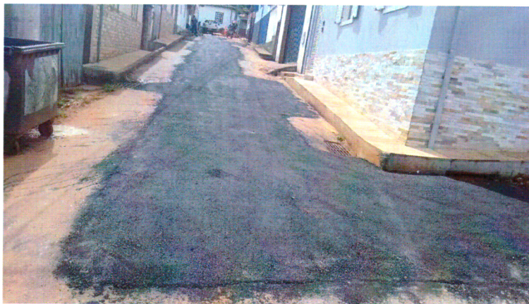
REPAVIMENTAÇÃO RUA JOÃO XXIII (01/03/2024)
