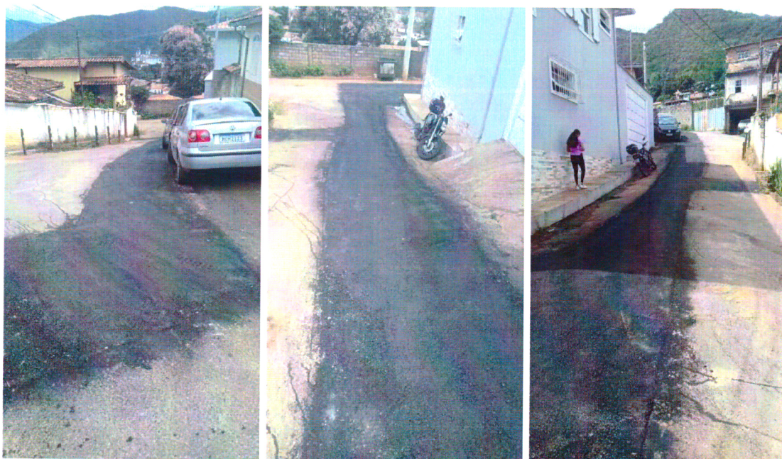
REPAVIMENTAÇÃO RUA JOÃO XXIII (01/03/2024)
