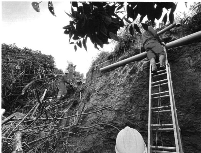
REDE DE ESGOTO, PARQUE DAS CANDEIAS (30/04/2024)
