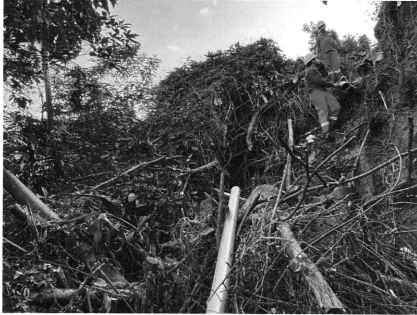
REDE DE ESGOTO, PARQUE DAS CANDEIAS (30/04/2024)
