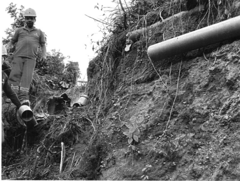
REDE DE ESGOTO, PARQUE DAS CANDEIAS (30/04/2024)
