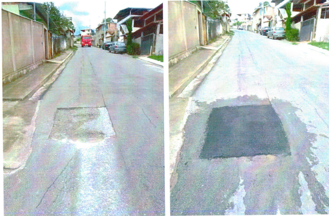
RECOMPOSIÇÃO ASFÁLTICA À RUA BONFIM, N.º 116, AMARANTINA (28/01/2025)
