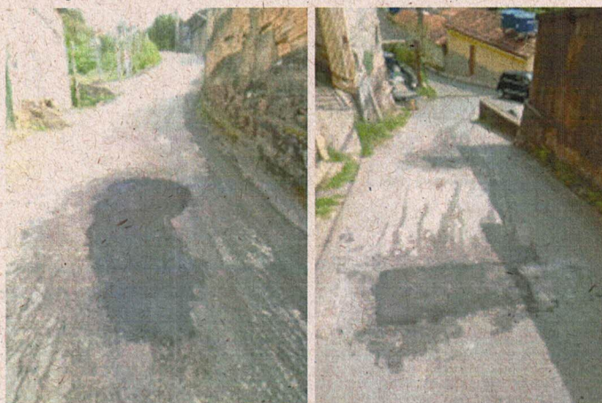
IMAGEM 1. RECOMPOSIÇÃO ASFÁLTICA À RUA FRANCISCO ISAAC, PADRE FARIA (04/04/2025)
