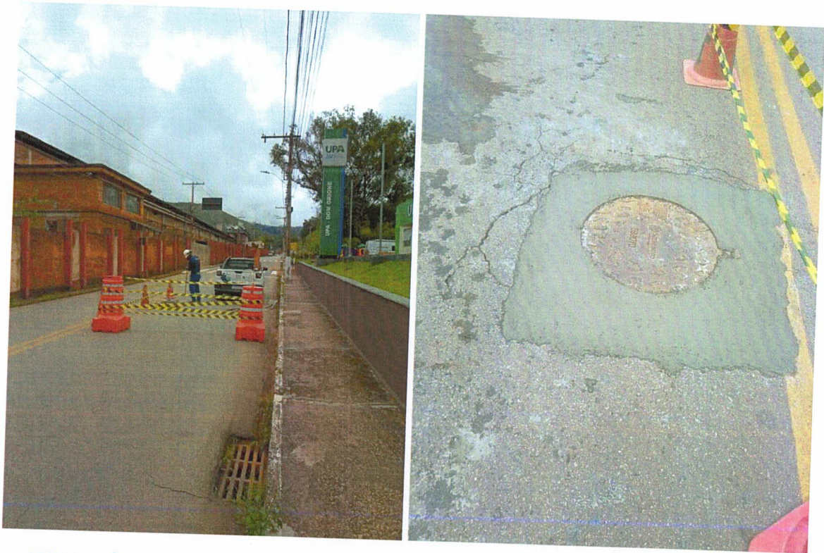
DESOBSTRUÇÃO DE ESGOTO E ELEVAÇÃO DE PV: AV. AMÉRICO RENNE GIANNETTI, UPA DOM ORIONE. PROTOCOLO N° 3120402.
