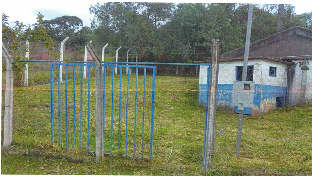
FIGURA 2. LIMPEZA E MANUTENÇÃO DE ÁREA DE RESERVATÓRIO, RUA MARMELADA (11/06/2025)
