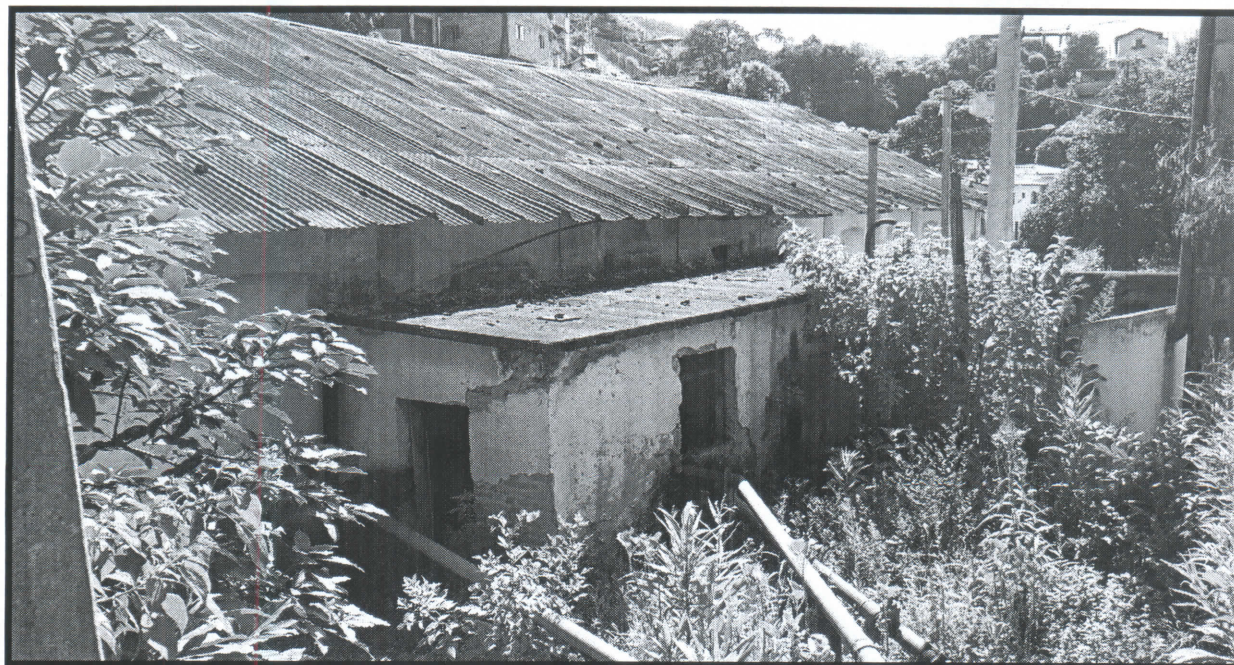
Vista interna do Reservatório Caixa III
