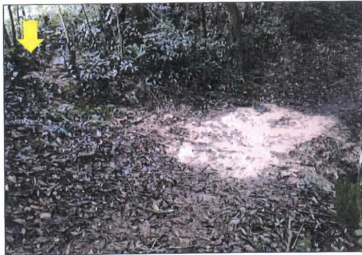
Figura 5: Ponto de surgência indicado em amarelo, com material carregado a jusante (19/05/2019).
