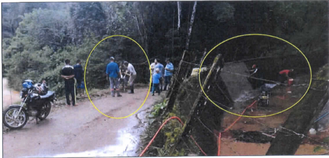
Figura 6: Atividades de instalação de marco de referência, à esquerda, e de vedação do canal, à direita, em andamento (19/05/2019).
