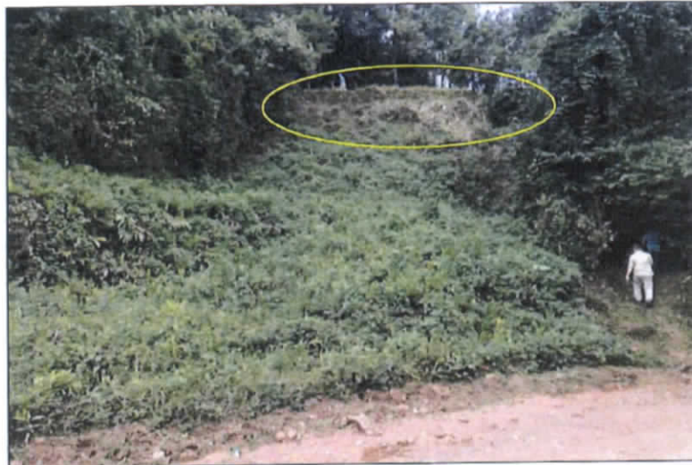
Figura 2: Vista de baixo para cima do talude avaliado, com muro de arrimo no terço superior (19/05/2019).
