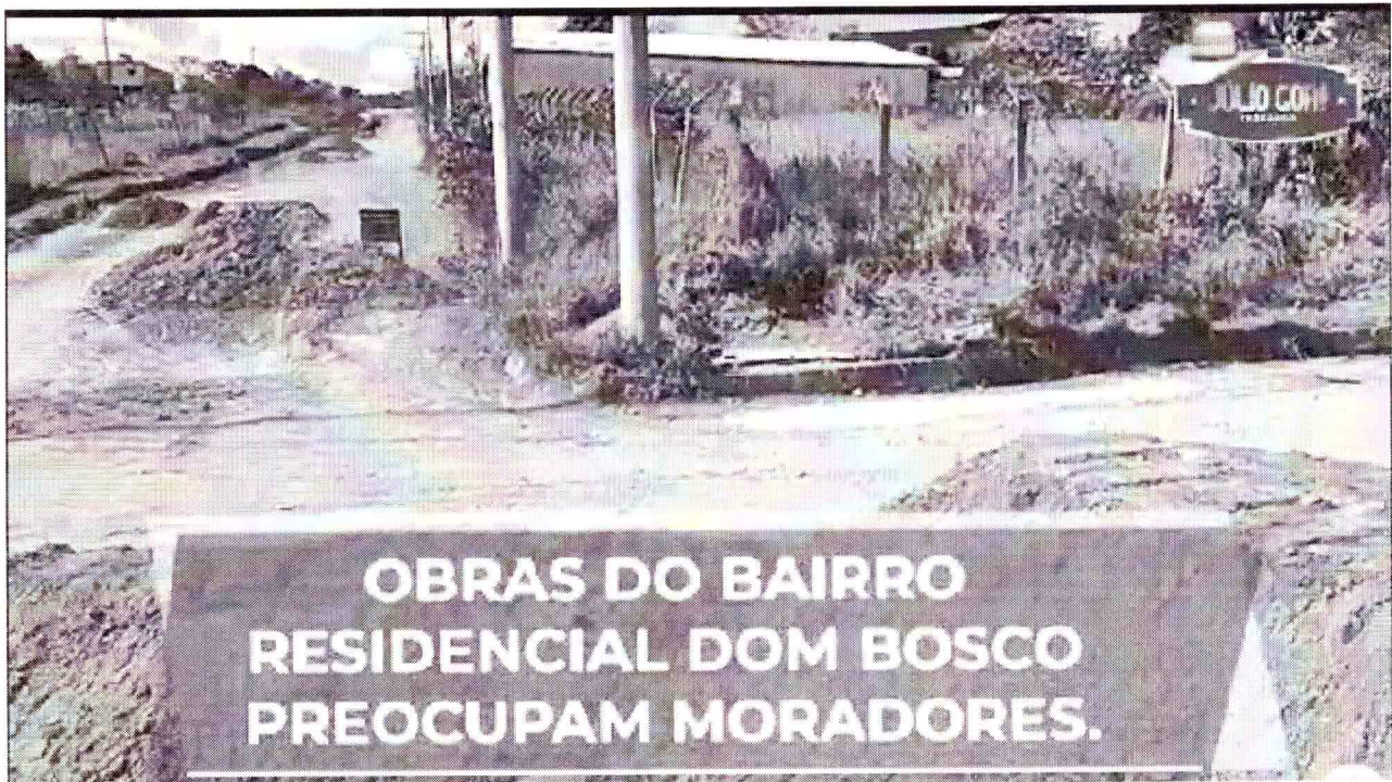
03/07/2023 - Fiscalização na obra Residencial Dom Bosco – Cachoeira do Campo
