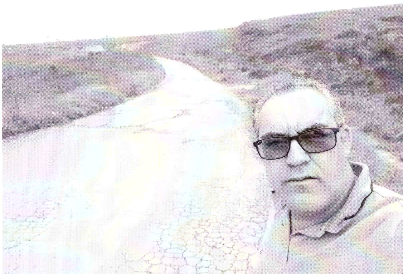
Visita na estrada da Chapada subdistrito de Santa Rita Data: 07/08/2023
