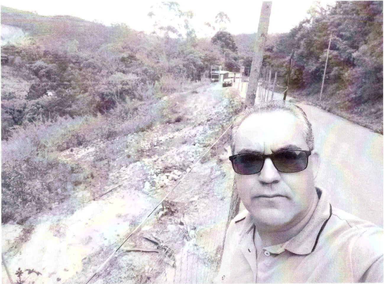
Visita na estrada do distrito de Rodrigo Silva Data: 16/08/2023
