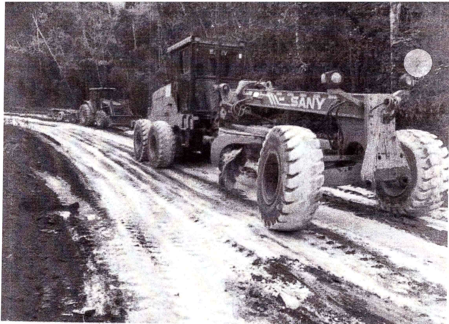
Catarina Mendes - manutenção na estrada
