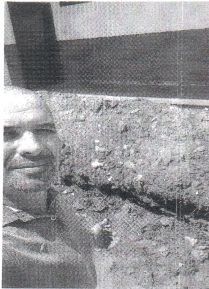
02/12/2023 – Fiscalização na obra no Campo da Água Limpa – Ouro Preto
