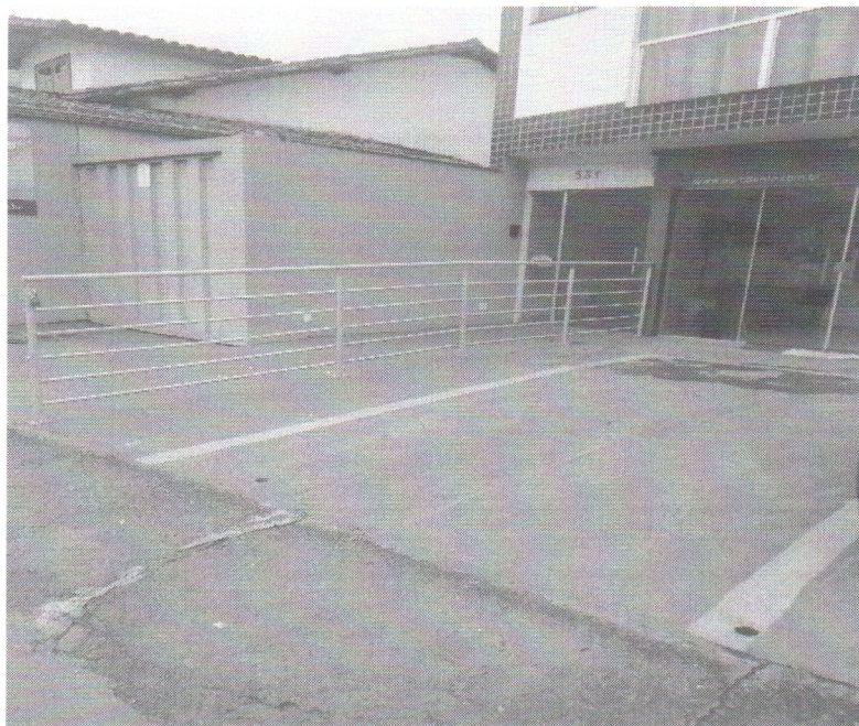
28/03/2024 – Fiscalização Avenida Juscelino Kubitschek (grades e bueiros) Ouro Preto
