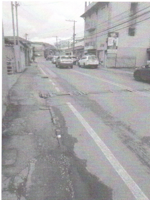
28/03/2024 – Fiscalização Avenida Juscelino Kubitschek (grades e bueiros) – Ouro Preto
