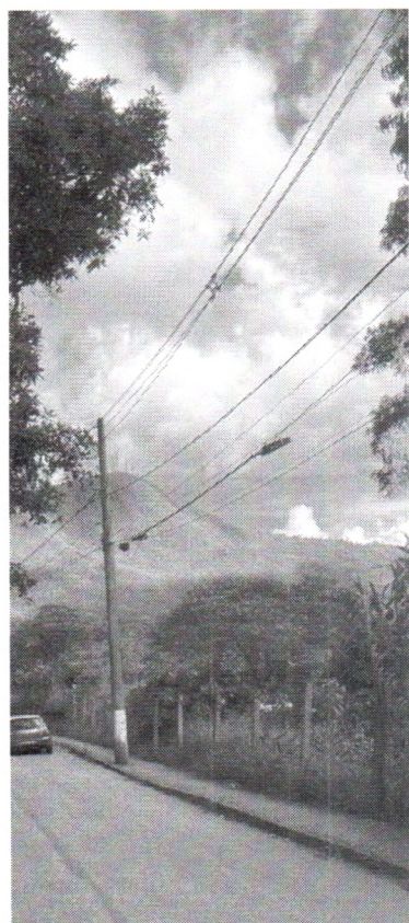
27/05/2024 - Fiscalização de necessidade capina na rua José Moringa no bairro Bauxita.
